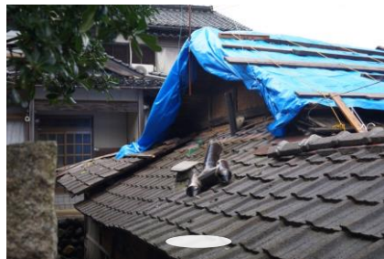
↑気高町姫路地区の被災状況
